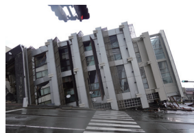
写真 2 転倒した鉄筋コンクリート造建物 鉄筋コンクリート造建物が転倒した原因については現在も調査が進められています。
