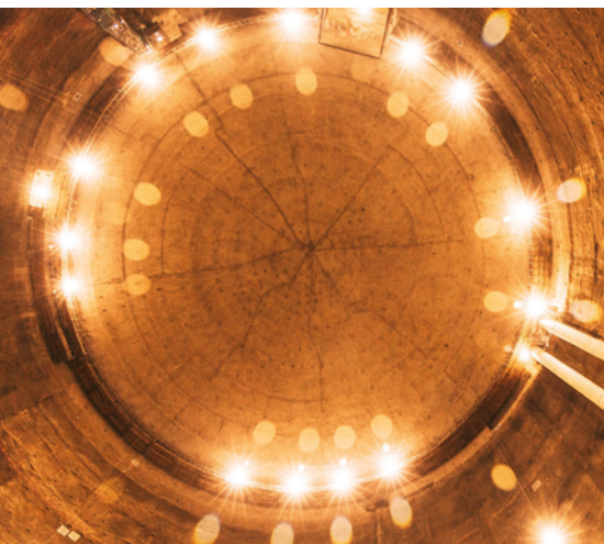
←天井ドーム部。ひびのように見えるのが計測器の配線。↑一連の掘削工事で田中先生が一番印象的だったという底部アプローチ坑道と本体空洞の貫通の瞬間（講演スライドより）。
