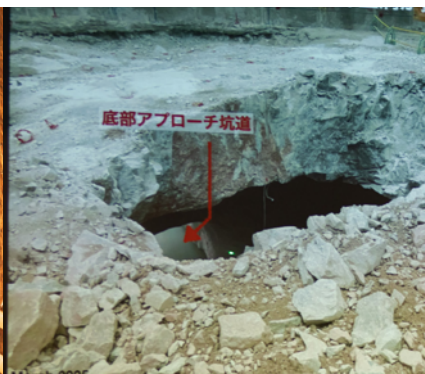
←天井ドーム部。ひびのように見えるのが計測器の配線。↑一連の掘削工事で田中先生が一番印象的だったという底部アプローチ坑道と本体空洞の貫通の瞬間（講演スライドより）。
