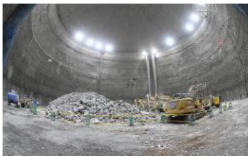
ハイパーカミオカンデ計画 完成した本体空洞ドーム部
