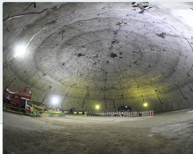
完成した本体空洞ドーム部(直径69m、高さ21m)
