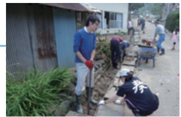
台風被害の復旧作業
