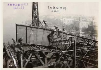
永代橋工事写真其五より；中央径間アーチリブの架設
